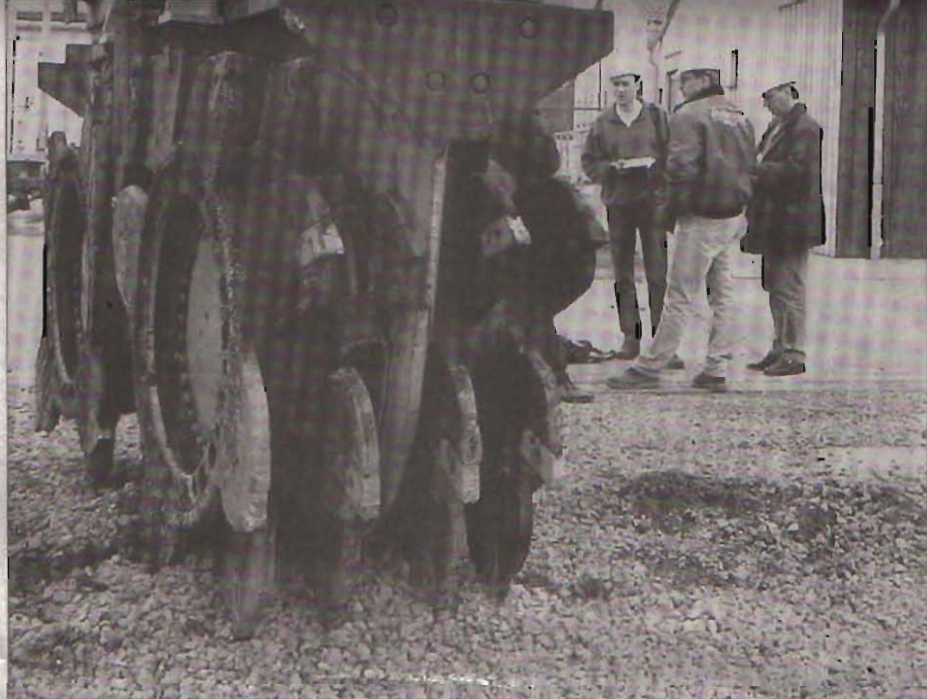
Diese starken „Zahn-Räder“ – mit widerstandsfähigem Widia-Stahl bestückt – sollen sich 30 Meter tief in den Boden wühlen, um auf der Deponie Münchhehagen Platz zu schaffen für eine 1250 Meter lange, 80 cm dicke Dichtwand zur Umschließung der Altlasten. Fotos: Heckmann
