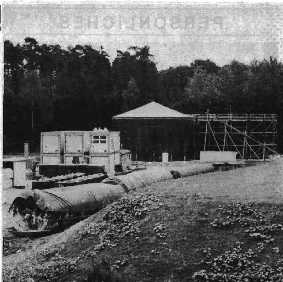
Der linke der beiden Hochbehälter auf der Sondermülldeponie enthält noch Wasser aus den Sickerschächten in den verfüllten Poldern, der rechte nur noch geringe Mengen Schlammreste aus Polder IV. Er wird in Kürze innen gereinigt, repariert und mit Folie ausgelegt. Fotos: Becker
