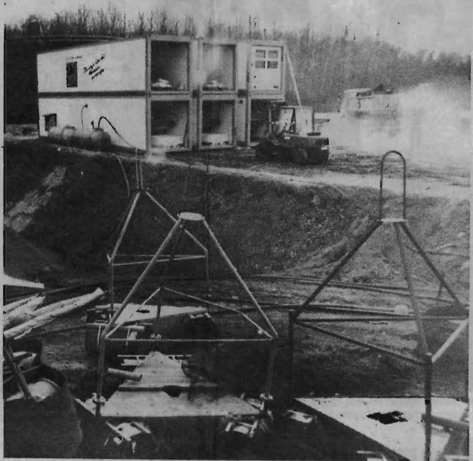
Mit den schon früher benutzten Pumpen im Vordergrund soll in Kürze das Wasser aus Polder IV b (links) zur Entgiftung in die Aktivkohlefilteranlage (hinten) befördert werden. Foto: Lange
