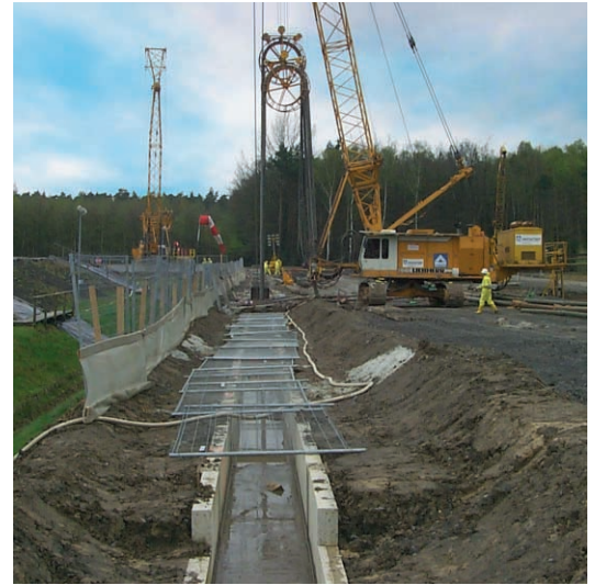
Abb. 4: Vorbereitung des Einsatzes der Schlitzwandfräse
