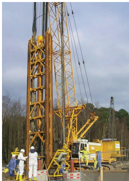
Abb. 1: Vorbereitung des Einsatzes der Schlitzwandfräse
