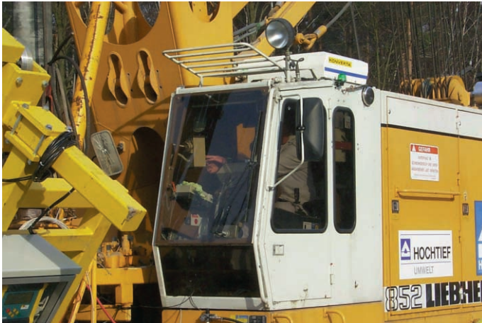
Abb. 6: Trägergerät der Schlitzwandfräse mit Atem-Druckluft-Anlage
