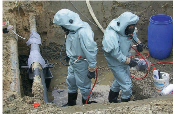
Abb. 7: Arbeiter mit Chemikalienschutzanzug und Druckluftschlauchgerät trennen Sickerwasserleitungen
