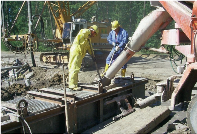
Abb. 9: Austausch der Stützsuspension gegen die Zweitmasse
