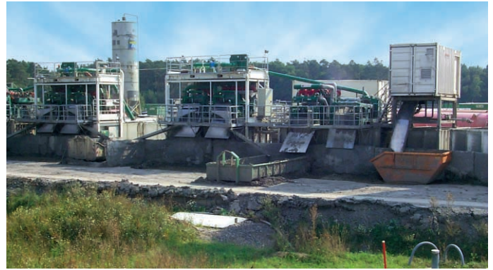
Abb. 9: Austausch der Stützsuspension gegen die Zweitmasse
