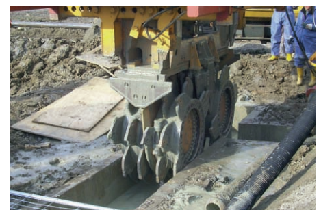
Abb. 2: Die Fräsräder der Schlitzwandfräse
