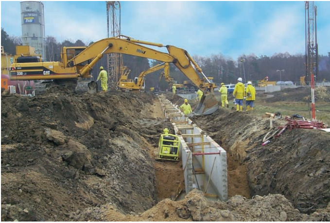
Abb. 3: Bau der Leitwand mit messtechnischer Begleitung
